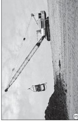
3. Der fertig geformte Sandkern wird mit einem meterdicken zähen Kleimantel abgedeckt. Das Material stammt aus dem alten Deich und diente zuvor für die Errichtung der Spüldämme.
