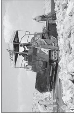
4. Der Deichfuß erhält eine Packung aus schweren Steinen und eine asphaltierte Überschlagsicherung. Hier wird die Kraft großer Sturmflutwellen gebrochen.
