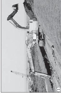
1. Bagger trennen den alten und unsicher gewordenen Kleideich auf. Aus dem Klei werden anschließend zwei Spüldämme für das Spülfeld geformt.
