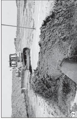
2. Ein Saugbagger draußen im Watt fördert Wattenmeersand über eine Röhrlleitung zur Baustelle. Das Wasser fließt am Ende des Spülleides wieder ab. Aus dem Sand formen Planterraupen den Sandkern.
