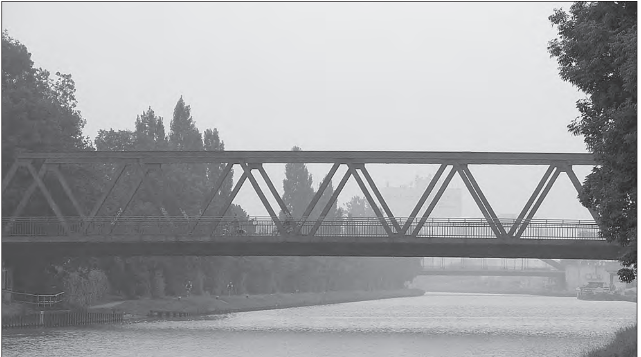
Abb. 1: Fachwerkbrücke mit oben liegendem Fachwerk (Fachwerk aus Streben)
