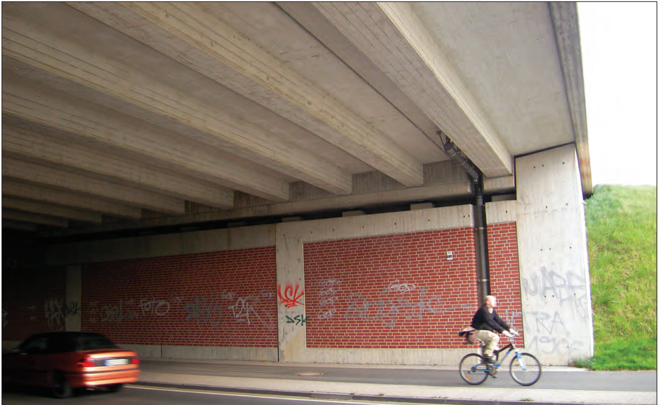
Abb. 1: Moderne Balkenbrücke mit Kastenprofilen
