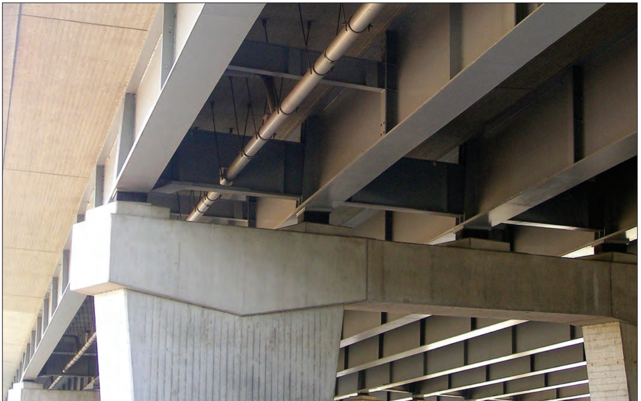
Abb. 2: Balkenbrücke mit Profilen aus Stahl unter der Brückenfahrbahn
