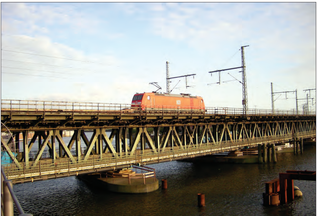
Abb. 2: Fachwerkbrücke mit unten liegendem Fachwerk (Fachwerk aus Pfosten und Streben)
