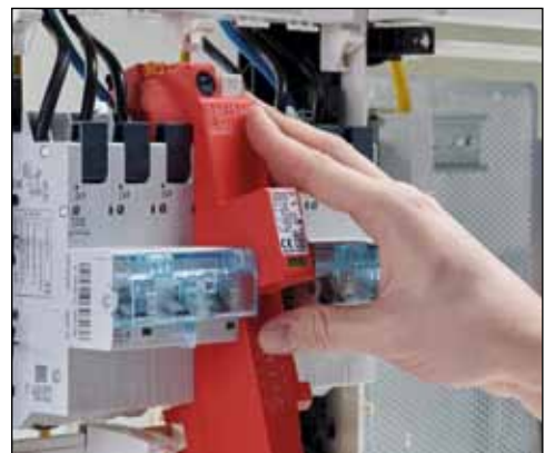
Abb. 2: Montage eines Kombibleiters im Zählerschrank
