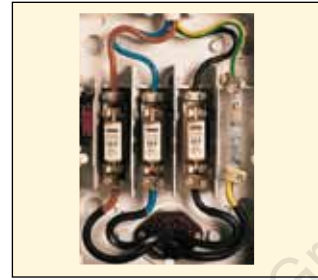
Abb. 1: HAK mit NH-Sicherungen
