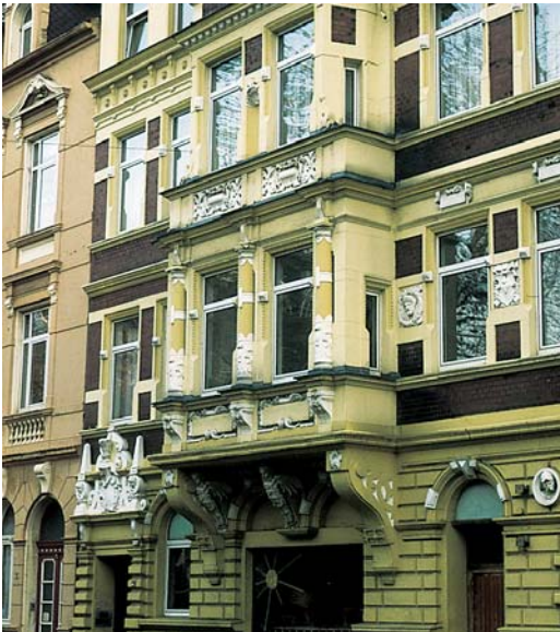
1. Dieses Gebäude soll einen neuen Fassadenanstrich erhalten
